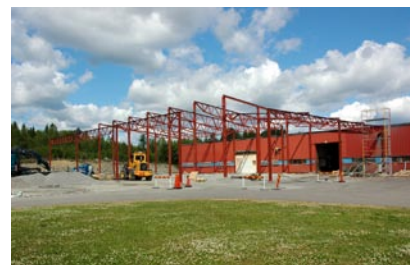
EdmoLift fabriksutbyggnad juli 2010
